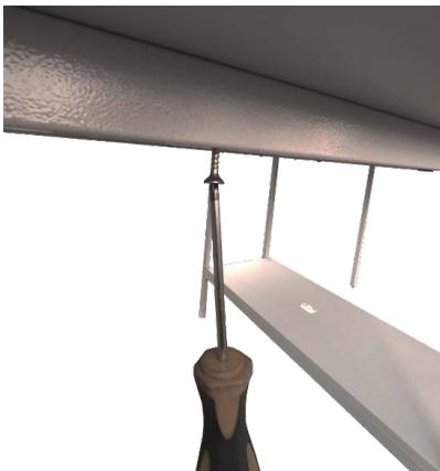
Для закручивания дсп используем отвертку, но быстрее и удобнее применить шуруповерт.
